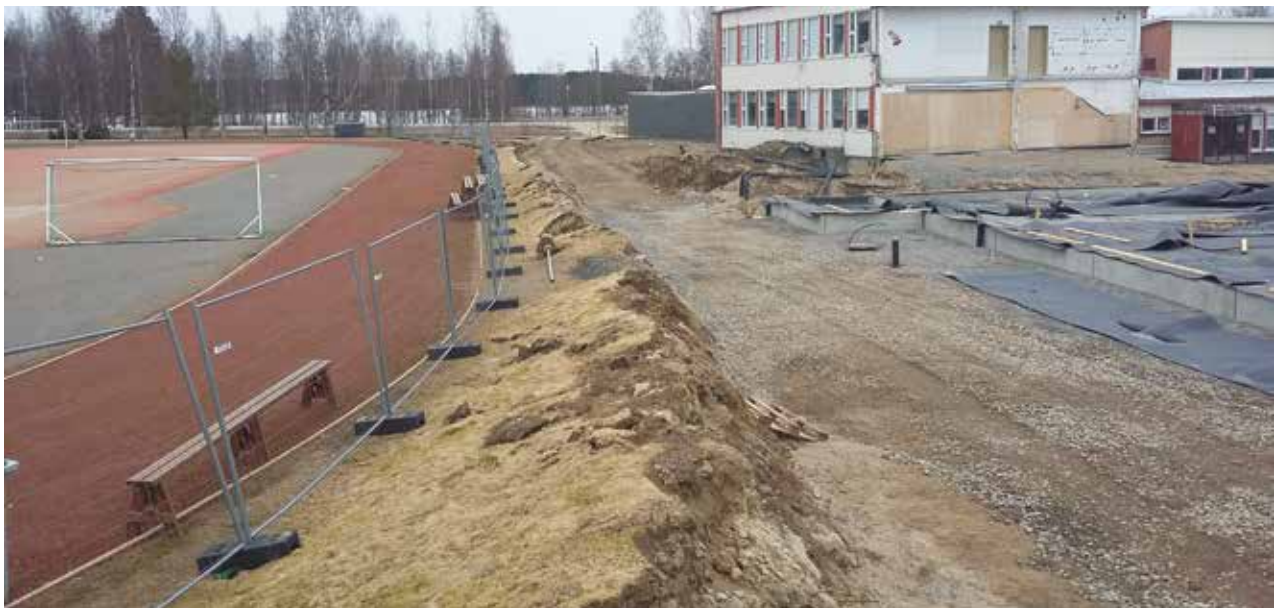
Uusi liikuntahalli rakennetaan vanhan paikalle koulukompleksin pohjoispäähän.
